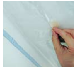
Fixes vapour barrier
